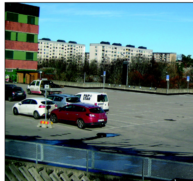
Parkeringsanläggning i Bredäng.
