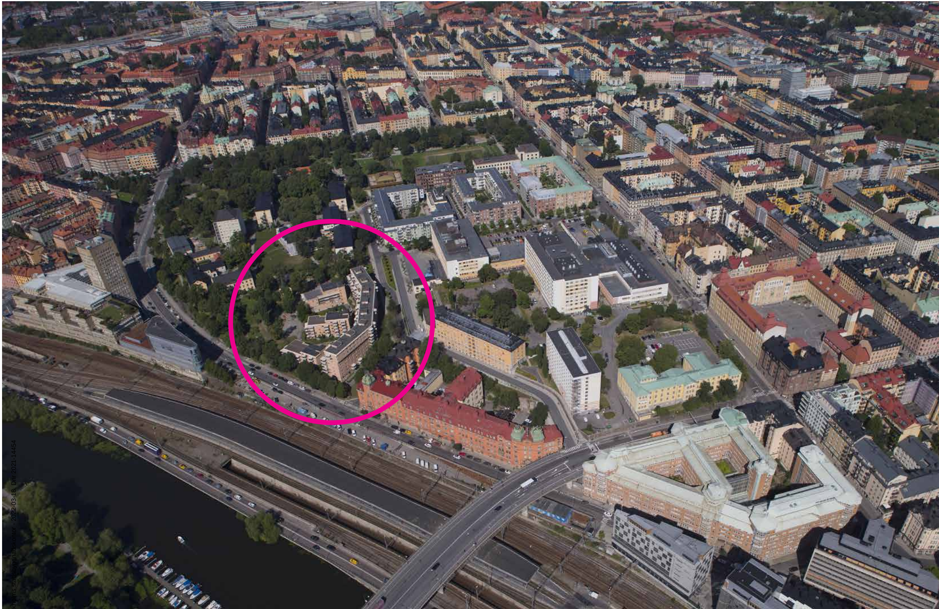
2022-05-09 SILVERSKOPAN Befintlig bostadsbebyggelse från 1980-talet
