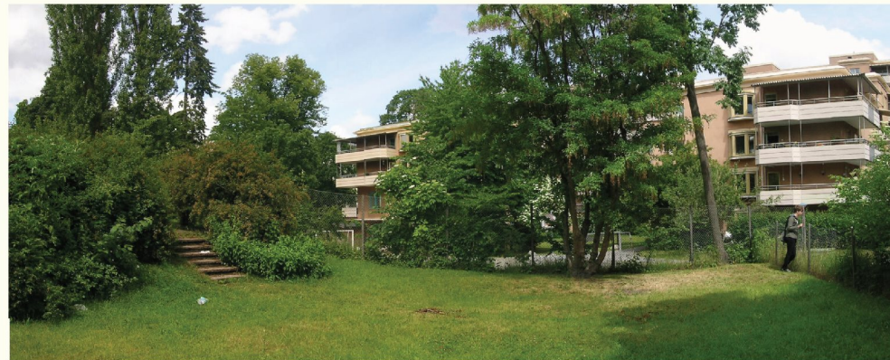
Relationen mellan Sabbatsbergs fruktträdgård och bebyggelsen på fastigheten Silverskopian 3. Trädgården samspelar med bebyggelsens skala.
