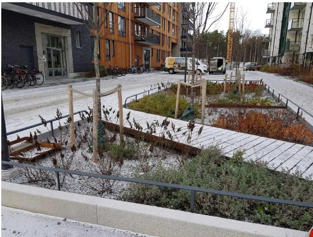
Figur 12. Sandfångskar och inlopp från Rosendal i Uppsala. Observera att inloppet till Södra parken måste vara betydligt bredare, gärna helt utan kantstensvisning.
