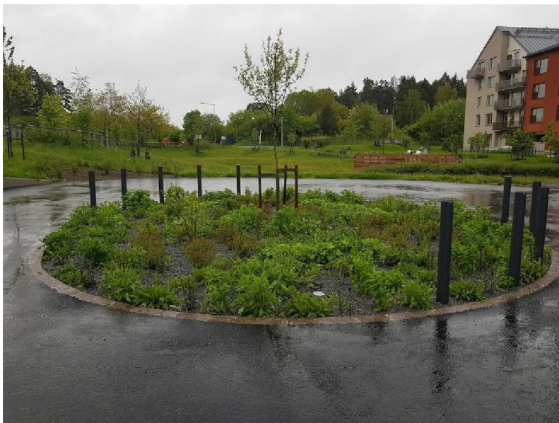
Figur 13. Nollad kantsten för rening OCH skyfallshantering i kolmakadam i Norra Djurgårdsstaden och Lidl Sigtuna stadsängar. Inspiration för inloppet till Södra parken.
