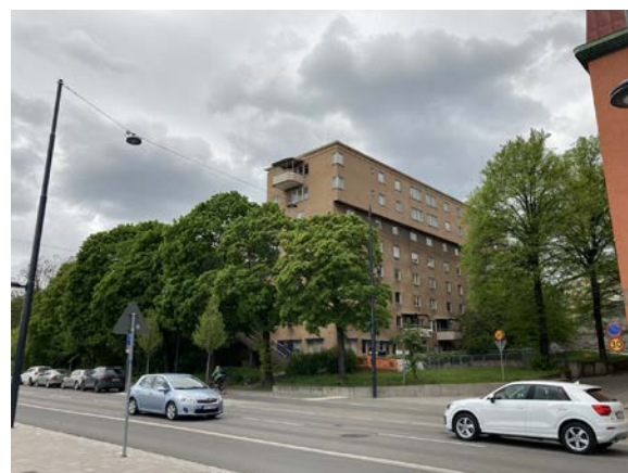
Silverskopan 3 ligger gränzonen mellan Sabbatsbergsparken och Torsgatan, men entréerna till parken är inte tydligt annonserade.
