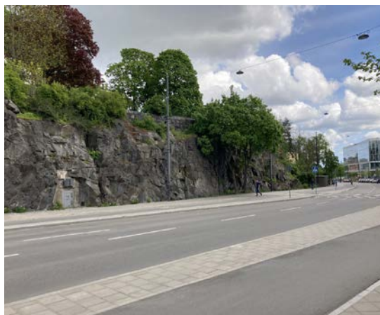
Norr om Silverskopan 3 höjer sig Bergsväggen och stänger av parken mot Torsgatan
