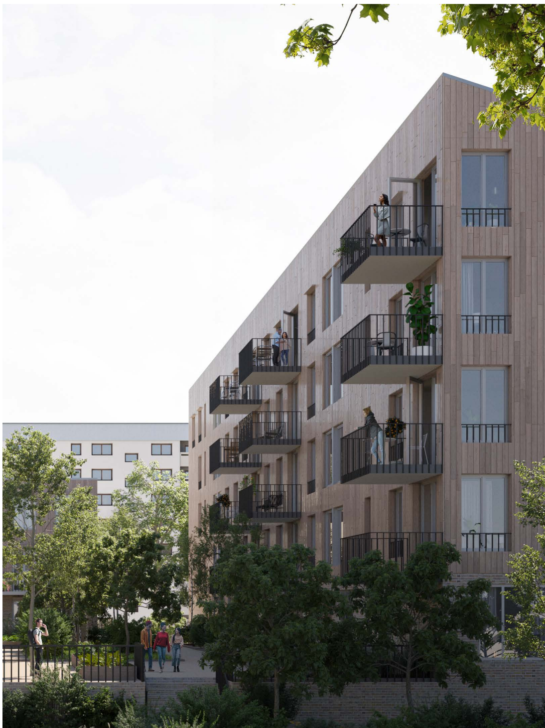
Bildexempel - balkonger mot gård med enkla pinnräcken, placerade ovan sockelväning
