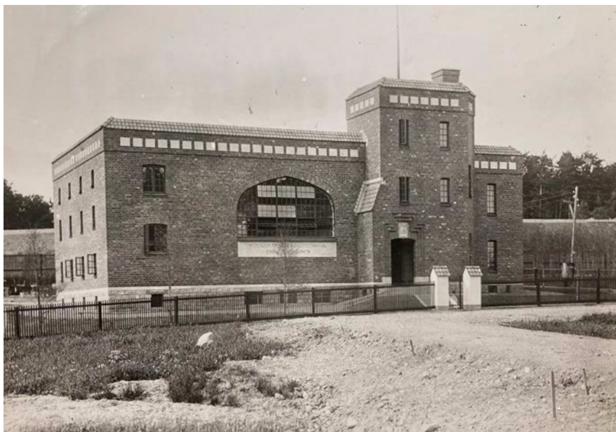
Befintlig elnässtation. Källa Stockholms stadsarkiv.
