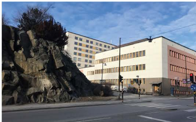
Bergsskärningen utmed Dalagatan, vy mot norr.
