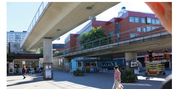
5. Tunnelbanan på viadukt av betong.
