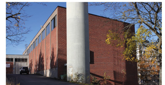
6. Panncentral vid centrum i tegelarkitektur.
