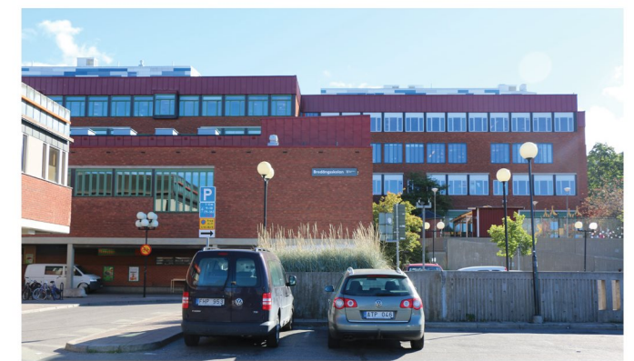
5. Bredängs gymnasium i tegelarkitektur.
