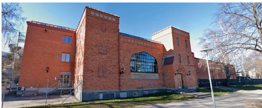
Gamla "Enskede elverk", byggår 1910/1970/1990, byggnaden är grönklassad.
