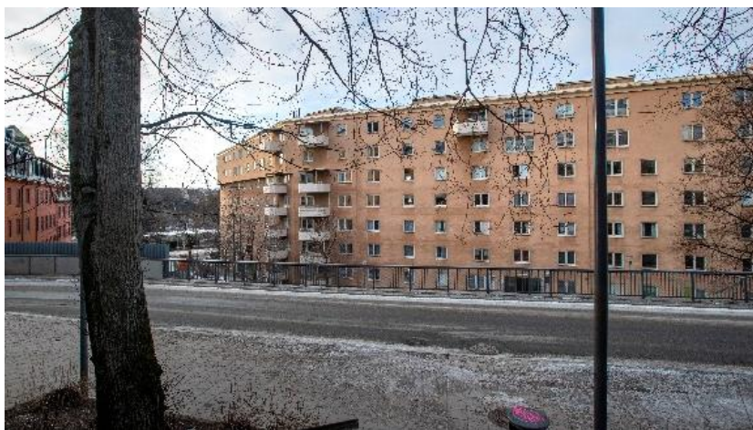
Fotografiet visar befintlig bebyggelse intill Torsgränds övre del. Närmast i bild syns parallellgatan Hälsobrunnsgatan. Källa: Stockholm Stad
