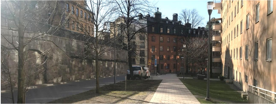
Figur 4 Torsgränd vid stödmuren, vy söder ut
