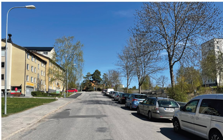
Vy 4 - Från Persikogatan mot norr - befintlig situation
