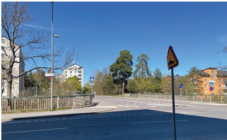
Vy 3 - Från korsningen Maltesholmsvägen och Melongatan - befintlig situation
