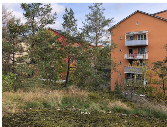
Delområde 5 i förgrunden med befintlig bebyggelse inom kv. Lekrummet i bakgrunden. Foto: Åsa Myhr, LandArk
