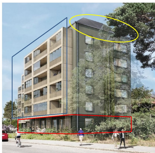
Detaljvy, sett från Melongatan, som redogör för principerna med föreskrivna gestaltungsprinciper: brantare taklutning i jämförelse till övrig bebyggelse inom planområdet (gul yta), balkonger som bedöms möjliga att glasa in (blå yta) samt den gestaltungsmissigt särskiljande bottenvåningen (röd yta). Bergkrantz Arkitektur
