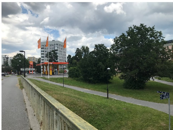
Till vänster syns befintlig drivmedelsstation inom delområde 3 som avses rivas. Foto: SBK
