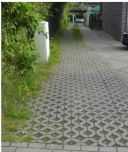
Figur 13. Exempel på genomsläpplig beläggning. 24
