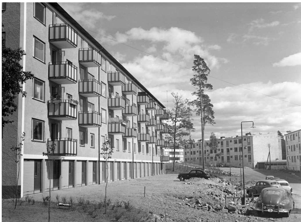
År 1957. Nybyggda hus på Fyrspannsgatan. Gatorna var ännu inte asfalterade vid fototillfället. Foto Olle Widfeldt, SvD. SSM
