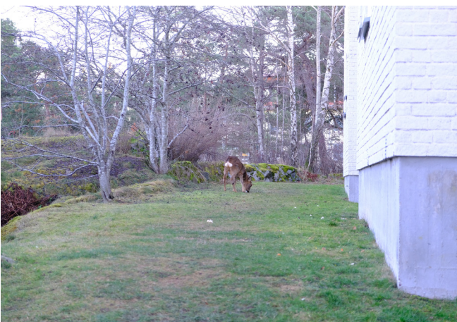
Bakom byggnaderna mot skogen tar naturmarken vid närapå omedelbart.
