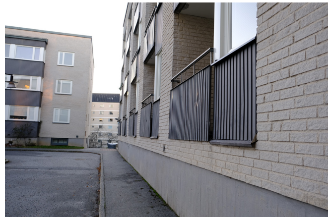
hus D till höger, med brädgjuten betongsockel, kalksandstensfasad, fönsterbröstningar och balkongfronter i korrugerad plåt, plåtinklädda fönster. Hus C till vänster med koppartak ovanpå den utskjutande plåtinklädda delen samt kopparsarg mot tak.
