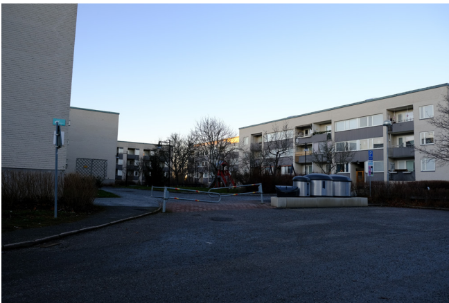
Från huvudentrén till gården. Gavlarna på hus B och C till vänster, längst bort hus D, till höger hus A med dess två sammankopplade lameller.
