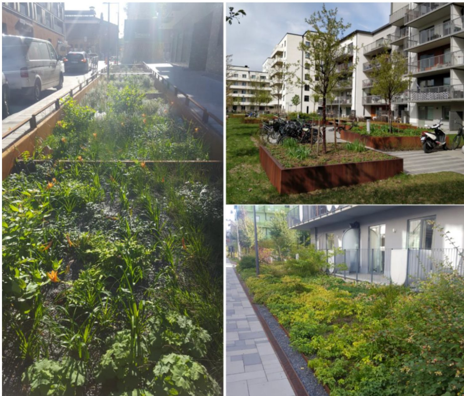
Figur 16. Till vänster visas en nedsänkt växtbädd på förgårdsmark i anslutning till lokalgata i Norra Djurgårdsstaden. Bilderna till höger visas växtbäddar i marknivå ovan bjälklag, den övre kommer från Östra Sala Backe och den nedre från Norra Djurgårdsstaden. Foto: Sweco
