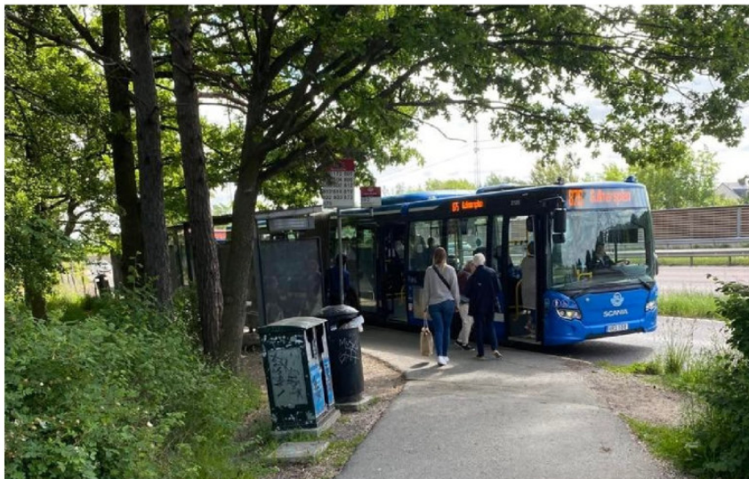
Busshållplatsen Norra Sköndal rymmer inte tillräckligt med bussfordon och planeras att byggas om.
