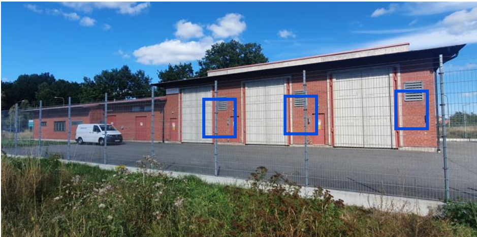
Figur 3. Transformatorhall med friskluftsintag markerade
