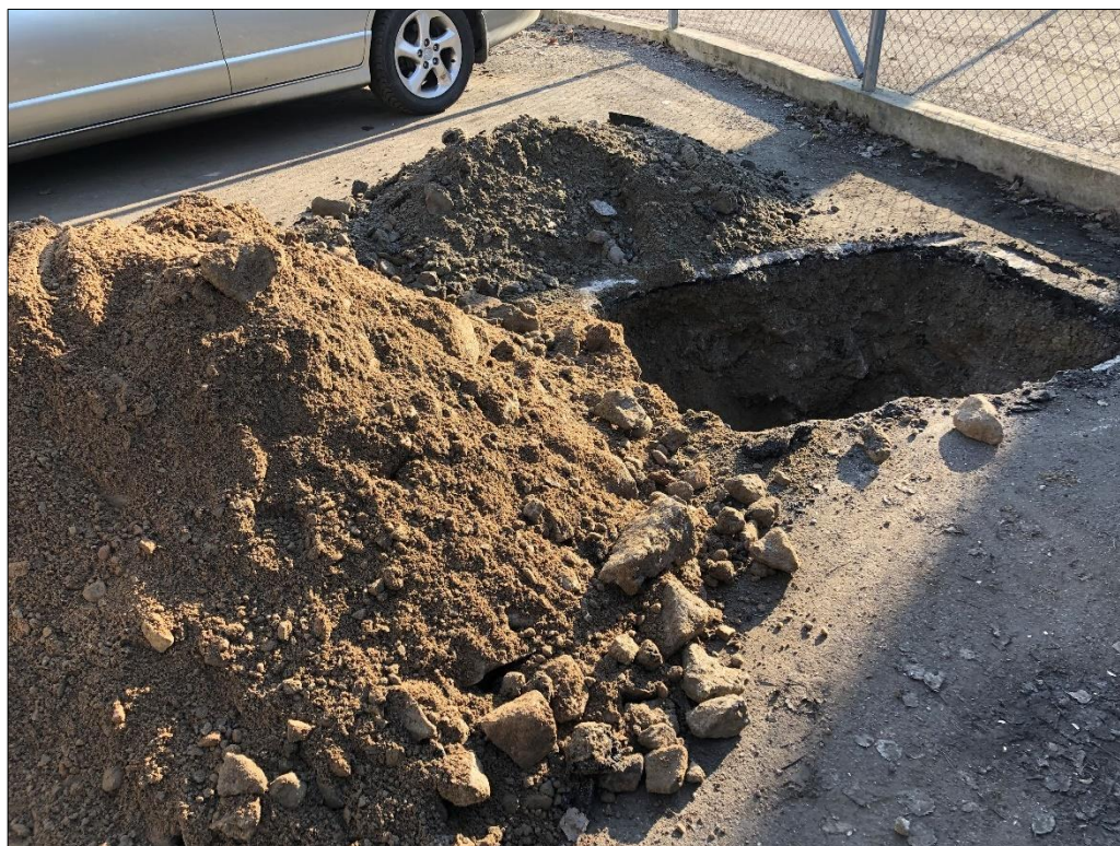
Figur 6. Prov uttogs på högat material från schaktgroparna. Bild från provgrop PG02 där den större högen utgörs av sand och den mindre av grusigt sandigt fyllnadsmaterial.
