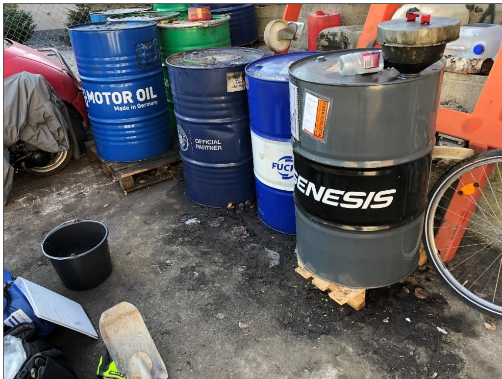
Figur 7. Oljeförorenad betongplatta.
