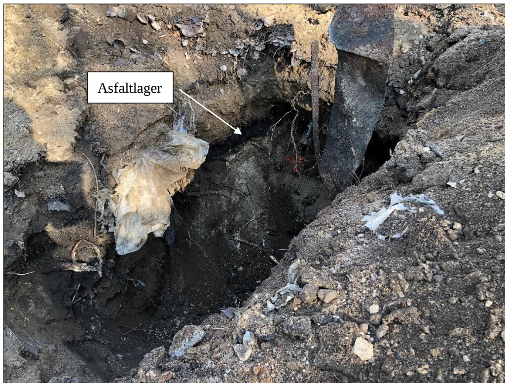
Figur 9. I PG06 påträffades diverse avfall. I provgroppens norra schaktvägg påträffades ett ca 20 cm tjockt asfaltlager.
