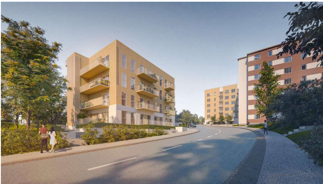
Vy från Bjursätragatans entré mot söder. Kvarter 11 till vänster och kvarter 10 till höger om gatan. (LuMe/White Arkitekter)
