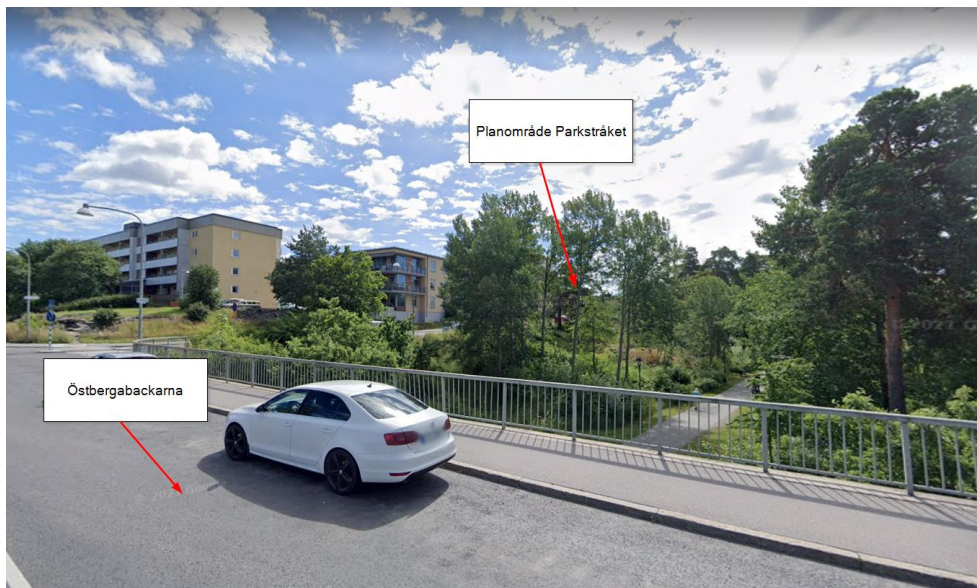
Figur 4. Bild visar planområdet sett från Östbergabackarna norr om planområdet. Bilden visar bron som går norr om Parkstråket.
