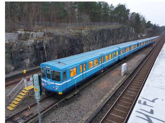
Figur 13. Tunnelbana i öppet tråg
