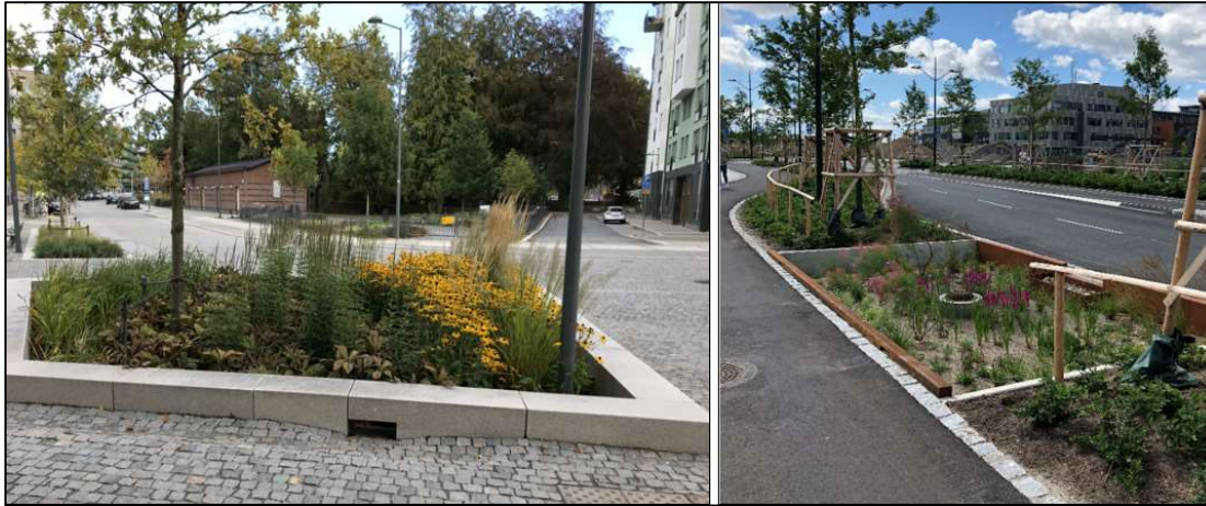
Figur 38. Exempel på nedsänkta regnbäddar (Foton: Norconsult).
