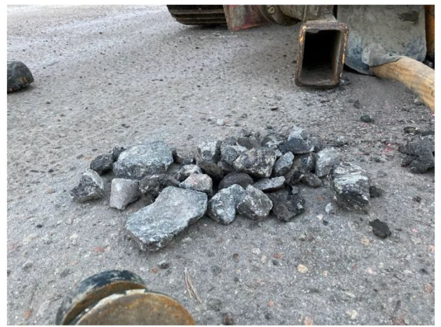
Bild 12. Material under asfalt, 21W28
