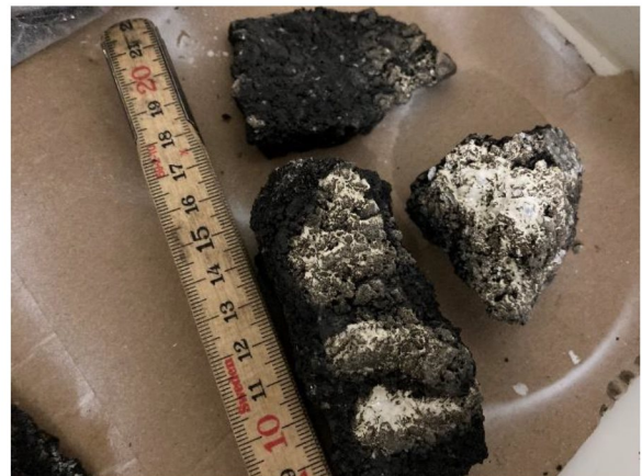
Bild 34. Asfalt från provpunkt 21W31
