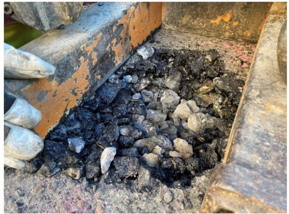
Bild 16. Material under asfalt, 21W30
