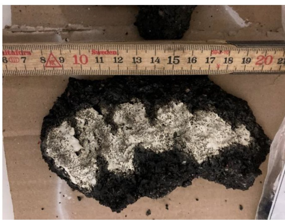
Bild 26. Asfalt från provpunkt 21W21
