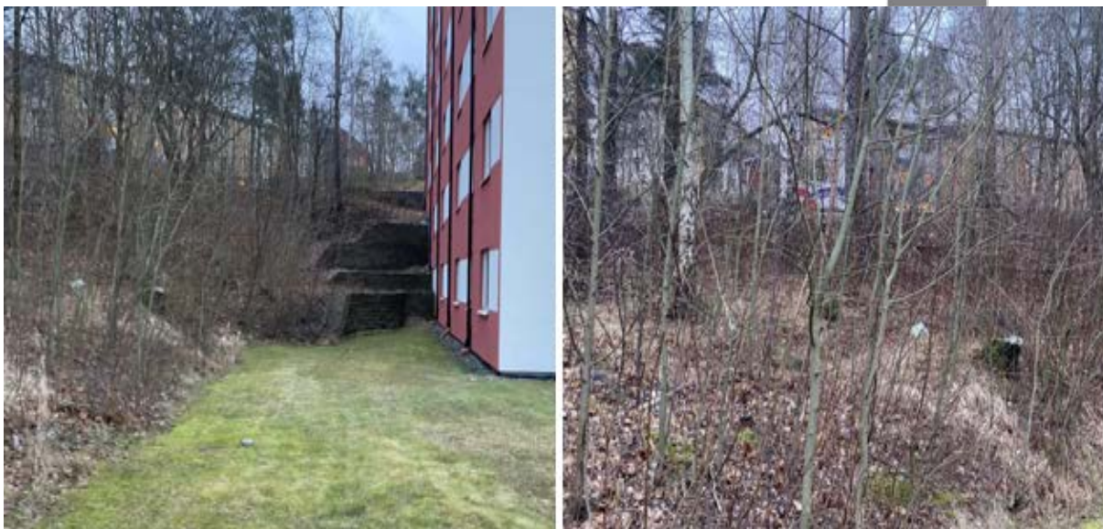
Bilder tagna vid platsbesök, 2022-01-19, GeoMind.
