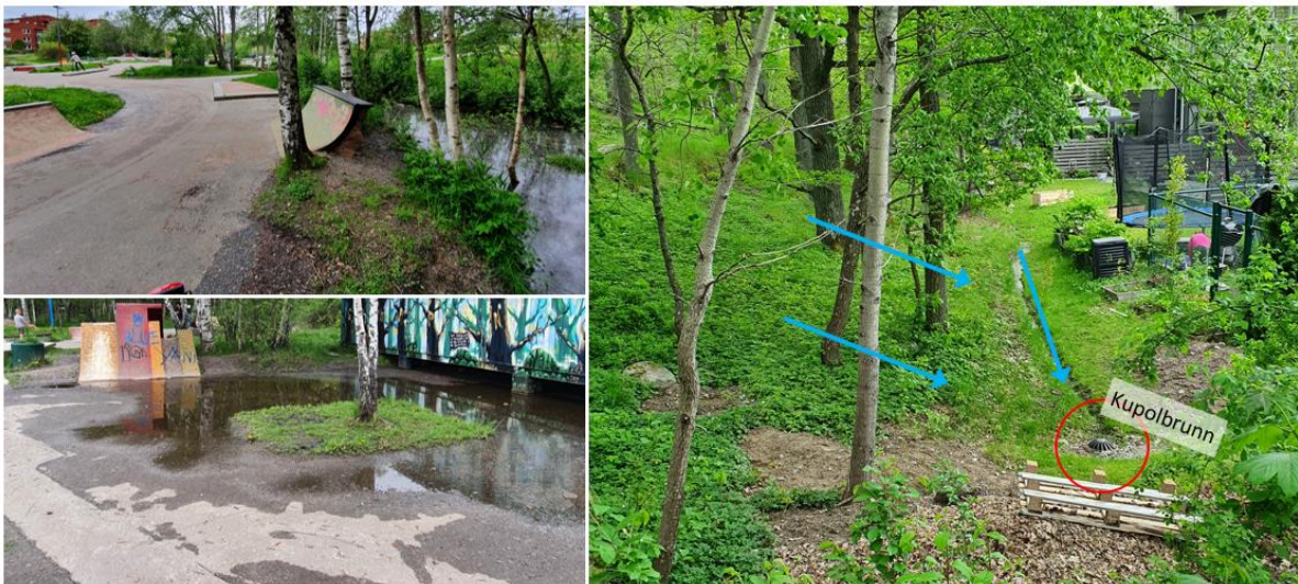
Figur 18. Bilder från platsbesök 2021-05-31. Till vänster stående vatten i skate-parken, till höger dike med kupolbrunn väster om radhusen utanför planområdets sydöstra hörn.
