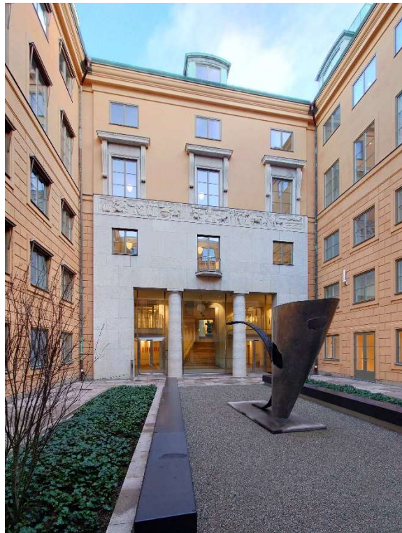
Samma vy efter ombyggnaden.
