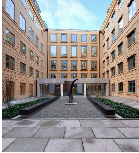
Samma vy efter ombyggnaden.
