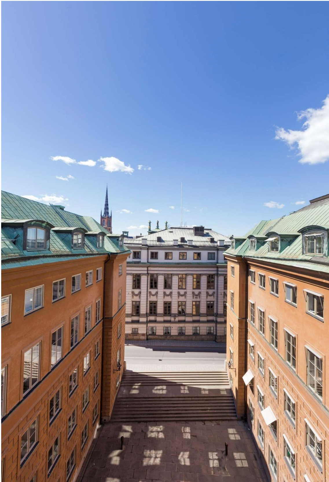
Västra gården före ombyggnaden. Foto: M Ek, SSM.
