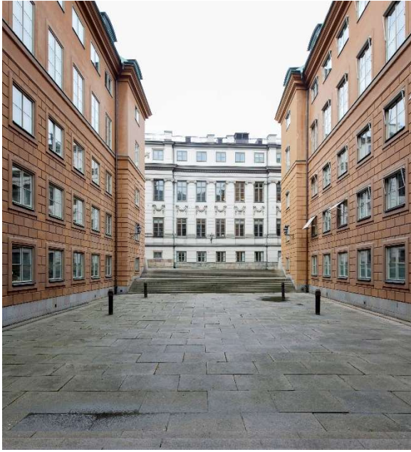
Västra gården västerut före ombyggnaden.
