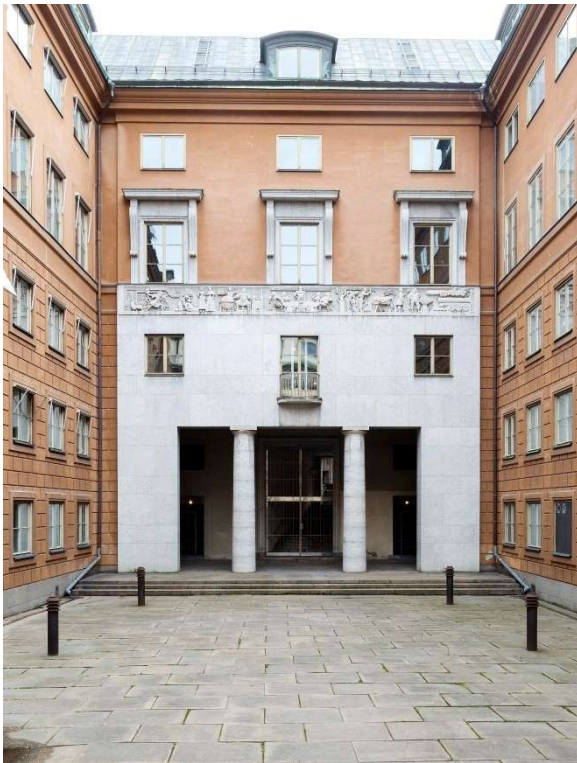
Västra gården österut före ombyggnaden.
