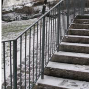
#2 Räcke med spjälor Plattstål
