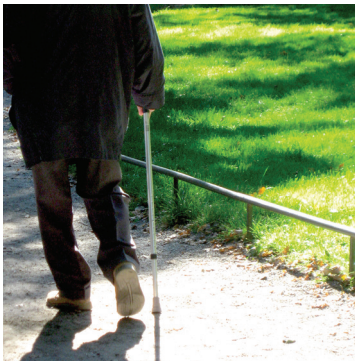
#7 Grovt räcke utan spjälor Rundstål Ø 40 mm
