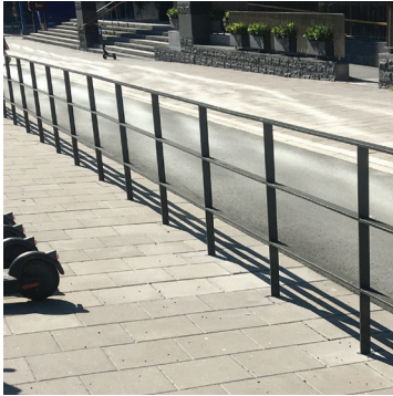
#1 Räcke utan spjälor Plattstål
