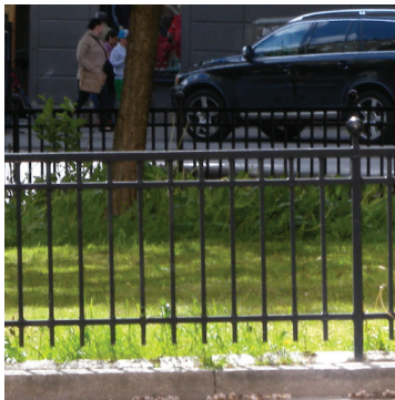
#8 Grovt planteringsräcke rundstål Ø 40 mm
