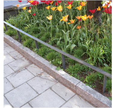
#3 Planteringsräcke Plattstål
