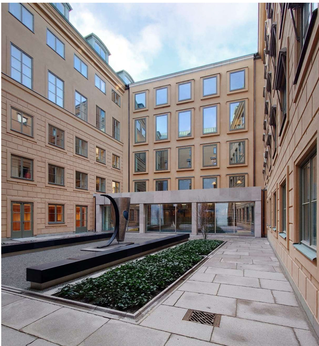
Tillbyggnadens gårdsfasad med sina utkragande fönsteromfattningar och på bottenvåningen hörsalens fasad i natursten och stora fönsteröppningar.
