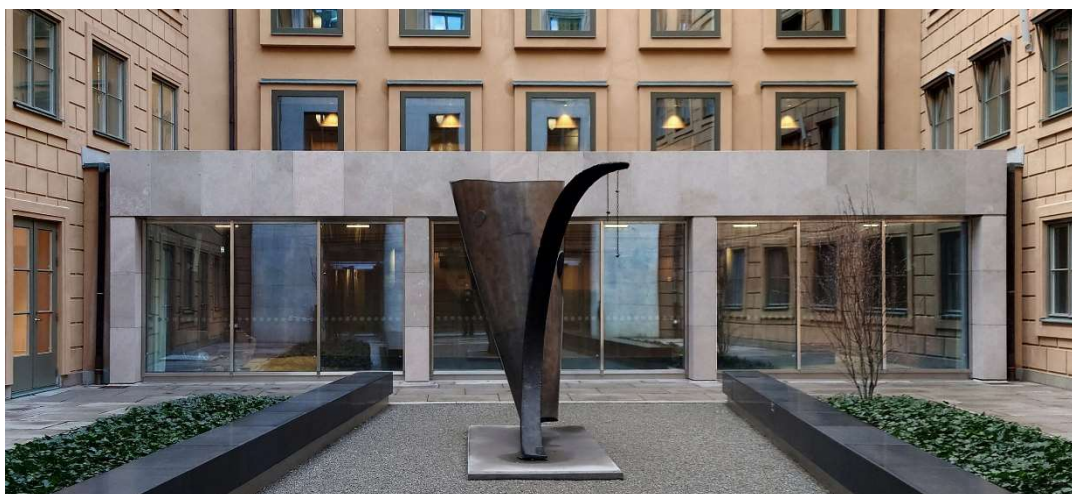
Tillbyggnadens och hörsalens nya fasader mot gården som också fått en ambitiös landskapsgestaltning.
