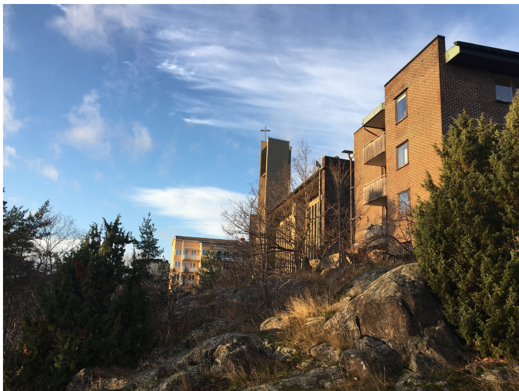
Klokryparen 6 och Klokryparen 5. Fasad mot sydväst.
