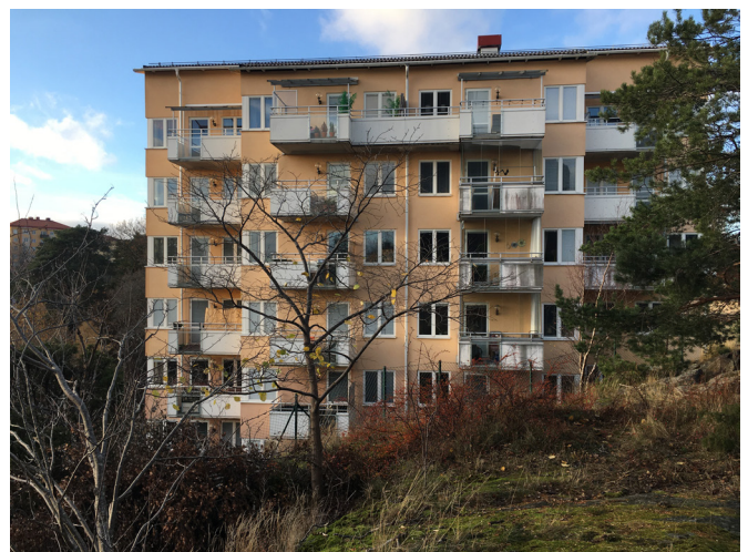
Klokryparen 4. Fasad mot sydost.
