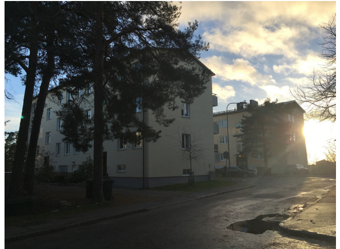
De smala lamellhusen i ljus putsad fasad karaktäriserar bebyggelsen i området.
