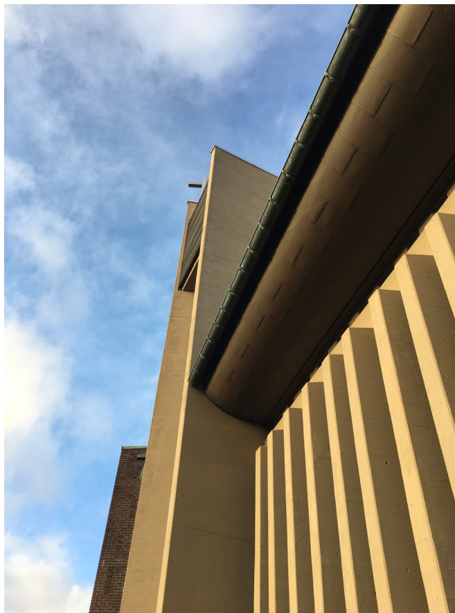
Klokryparen 5. Del av fasad mot sydväst.
