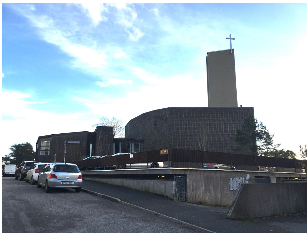
Klokryparen 5. Anläggningen med parkeringsdäck mot nordväst.
