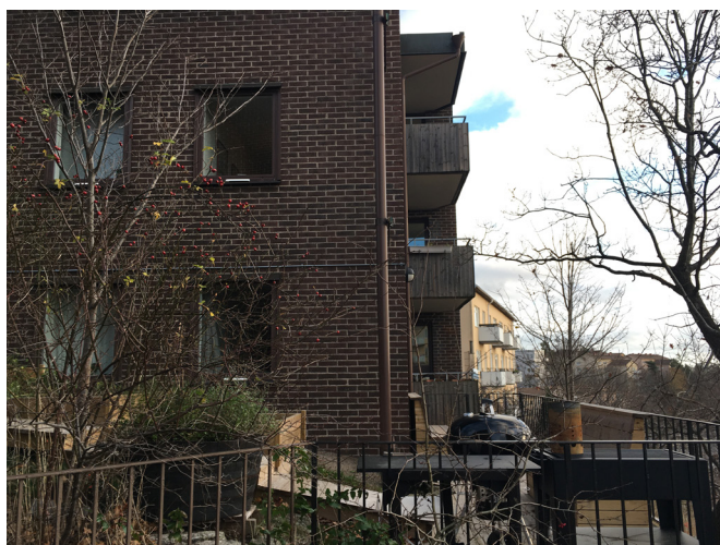
Klokryparen 6. Balkonger på gaveln mot sydväst.
