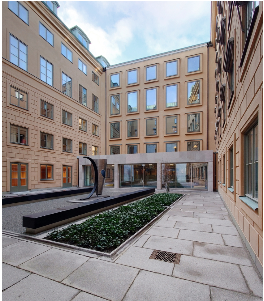
Tillbyggnadens fasad mot Västra gården. I suterräng mot gården syns ny hörsal. Foto: Paul Kvanta, Ahrbom och Partner
