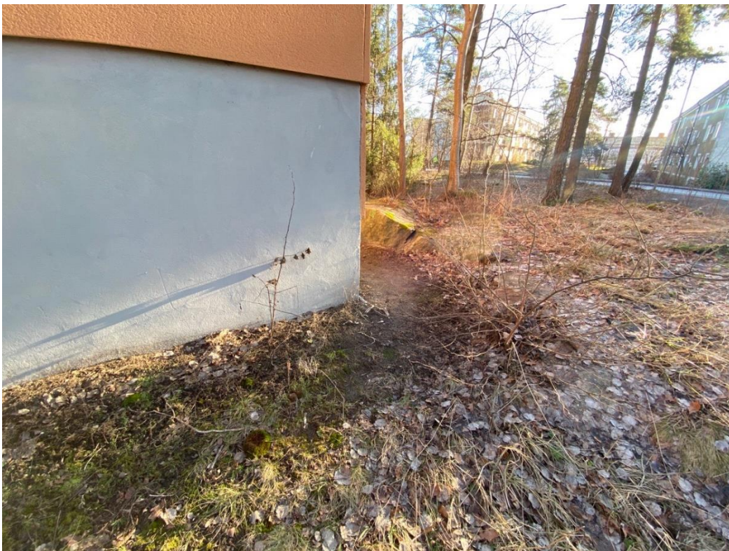
Figur 21. Bild på bräddpassagen från befintlig lågpunkt vid byggnadens sydvästra hörn. Bild tagen mot Västertorpsvägen.
