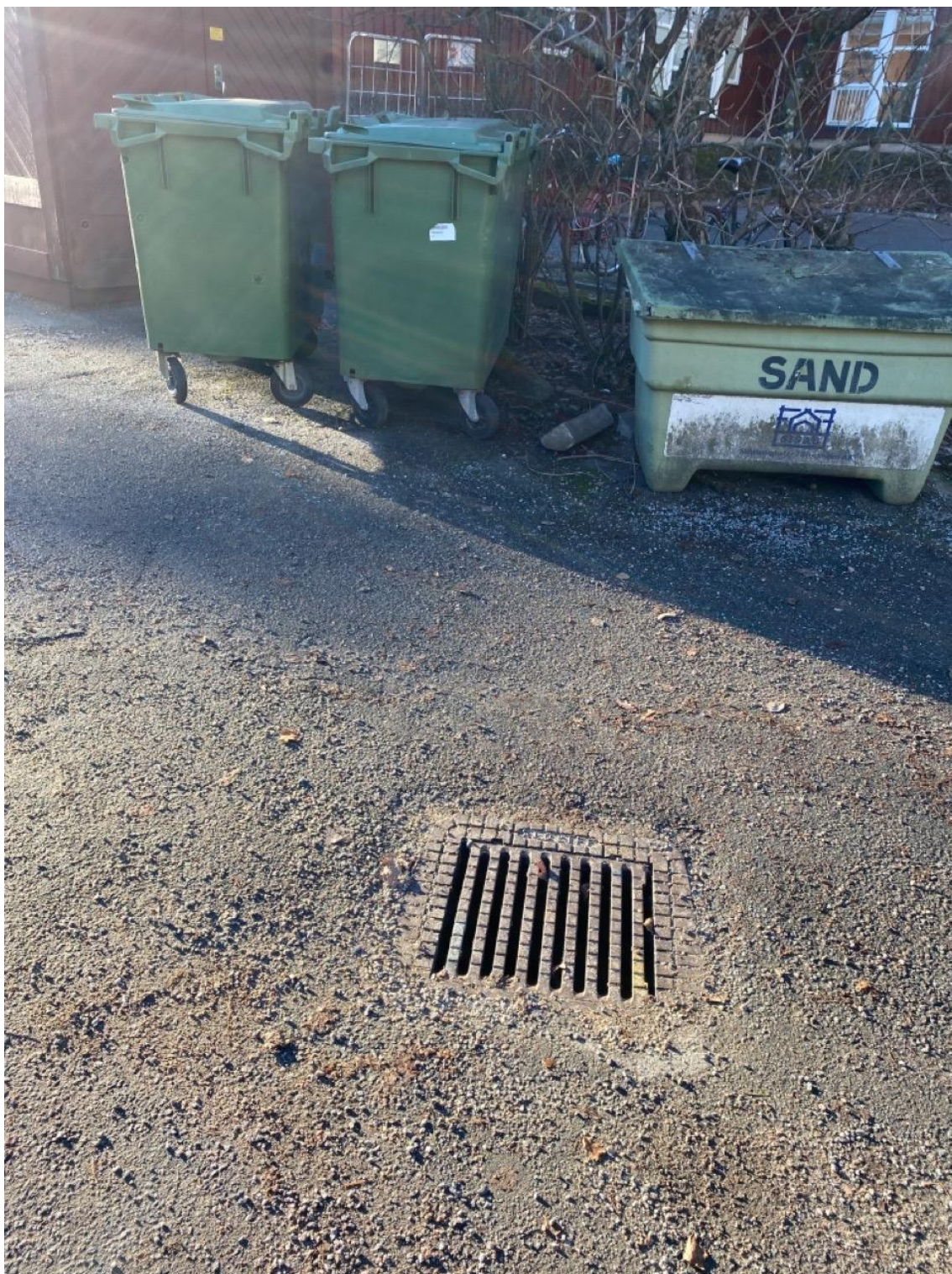
Figur 7. Befintlig dagvattenbrunn inom förskolafastigheten. Brunnen är kopplad till befintlig anslutningspunkt (bild tagen vid platsebsök 2023-01-30).
