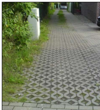
Figur 8-3. Exempel på genomsläpplig beläggning i form av gräsarmerad betongbeläggning (Stockholms Vatten och Avfall, 2017).
