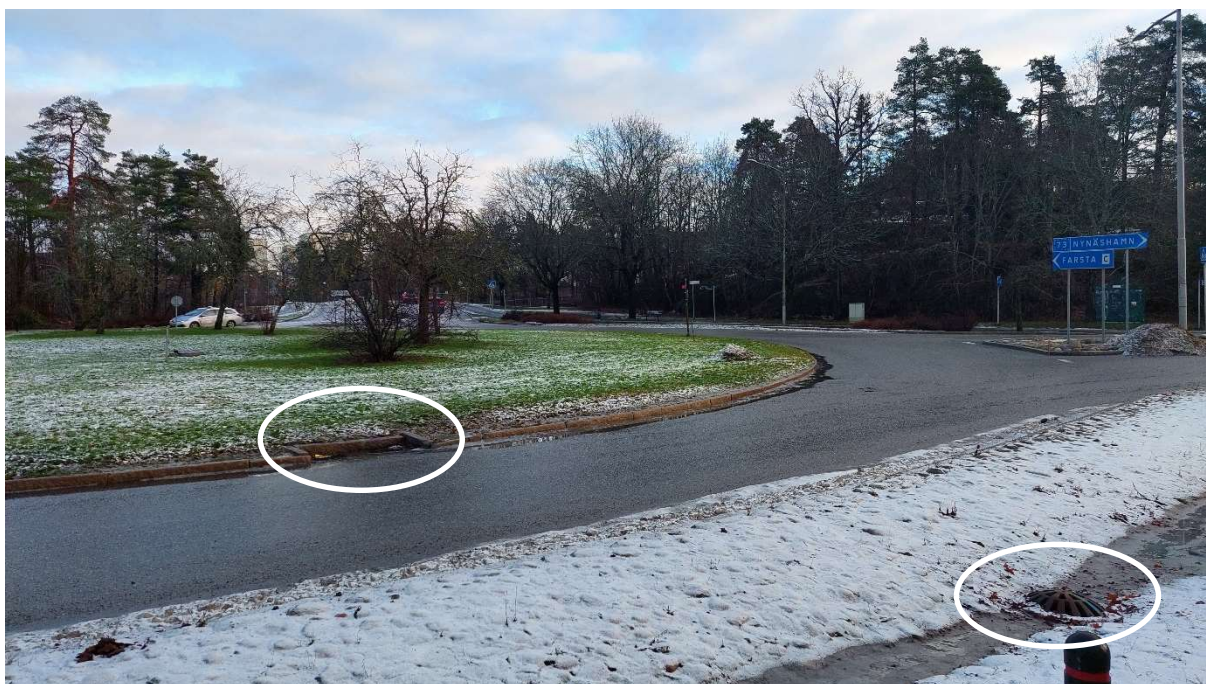
Figur 3-2. Dagvatten avleds till dagvattenbrunnar (vita ovaler) längs gatan.
