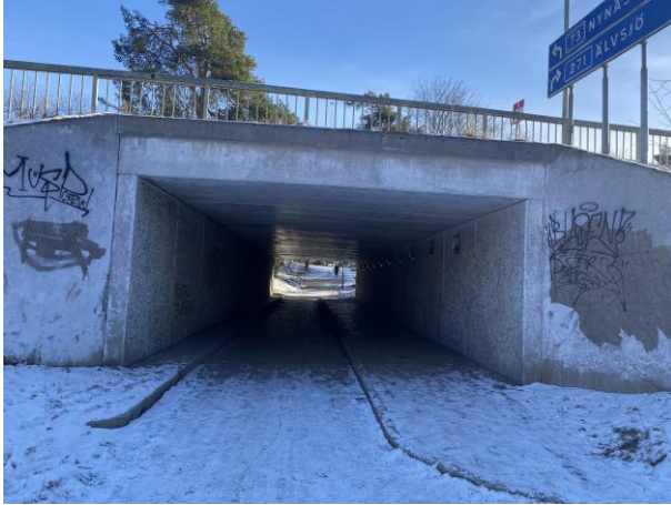
Figur 10. Gång- och cykeltunnel under Farstavägen sett från väster.
