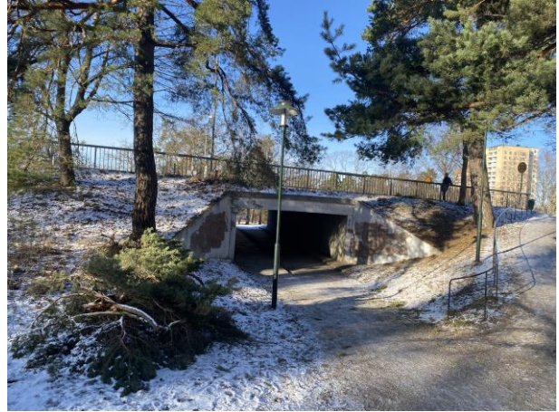
Figur 11. Gång- och cykeltunnel under Farstavägen sett från öster.
