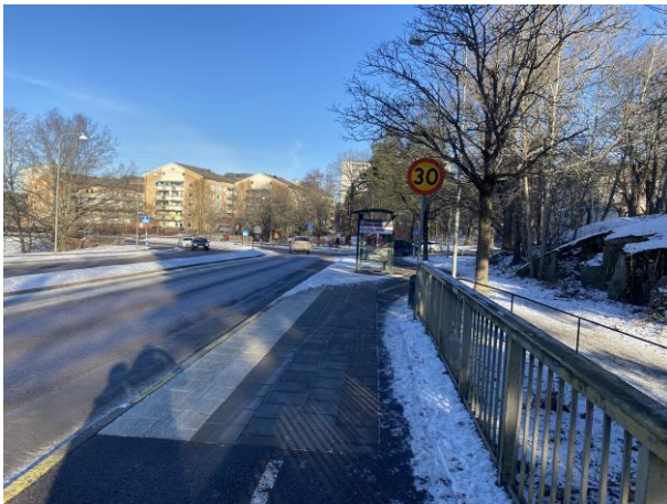
Figur 22. Hållplatsläge Kristinehamnsgatan på Farstavägen, i norrgående riktning.
