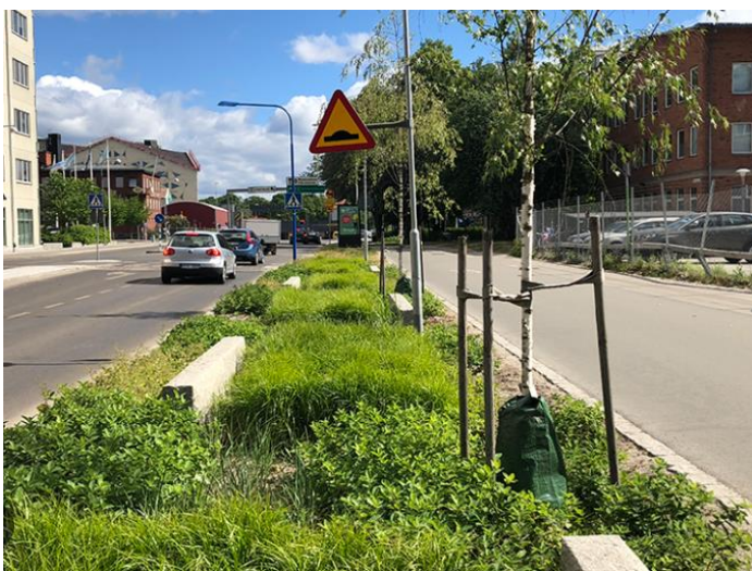
Figur 12. Exempel på utförande av regnväxtbädd.
