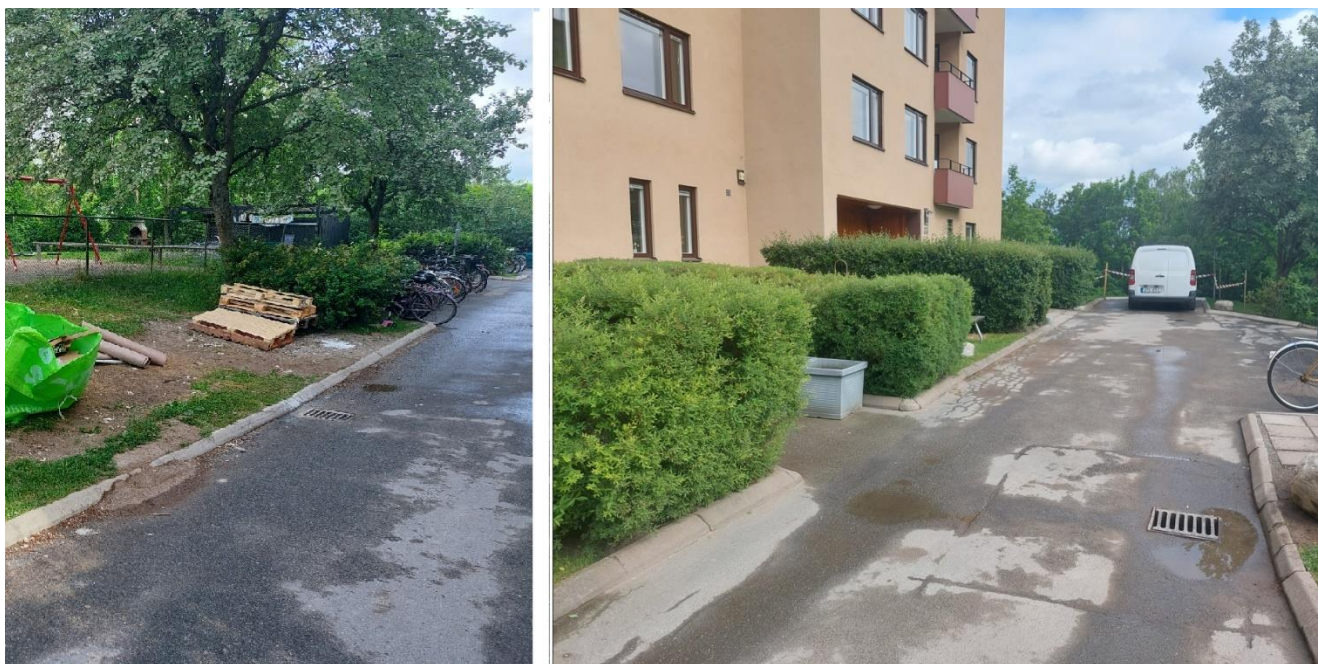
Figur 2–2. Dagvatten i östra delen avleds till dagvattenbrunnar.
