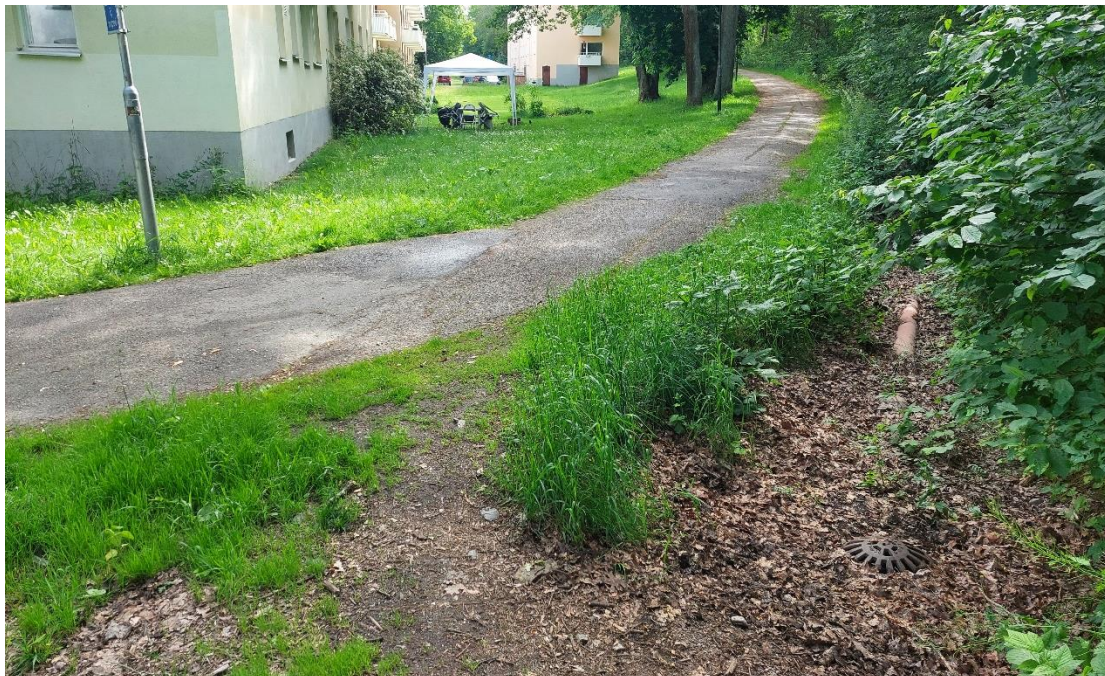
Figur 2-7. Gångväg norr om utredningsområdet nedanför stigen med en kupolbrunn gömd bland löv i bildens högra nederkant. Fotografi taget i östlig riktning.
