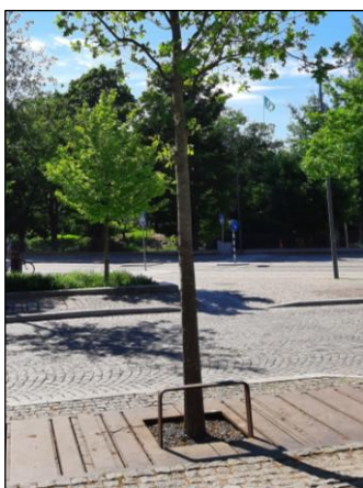
Figur 20 Trädplantering i skelettjord, med en mindre öppning för vatten att rinna ner.
