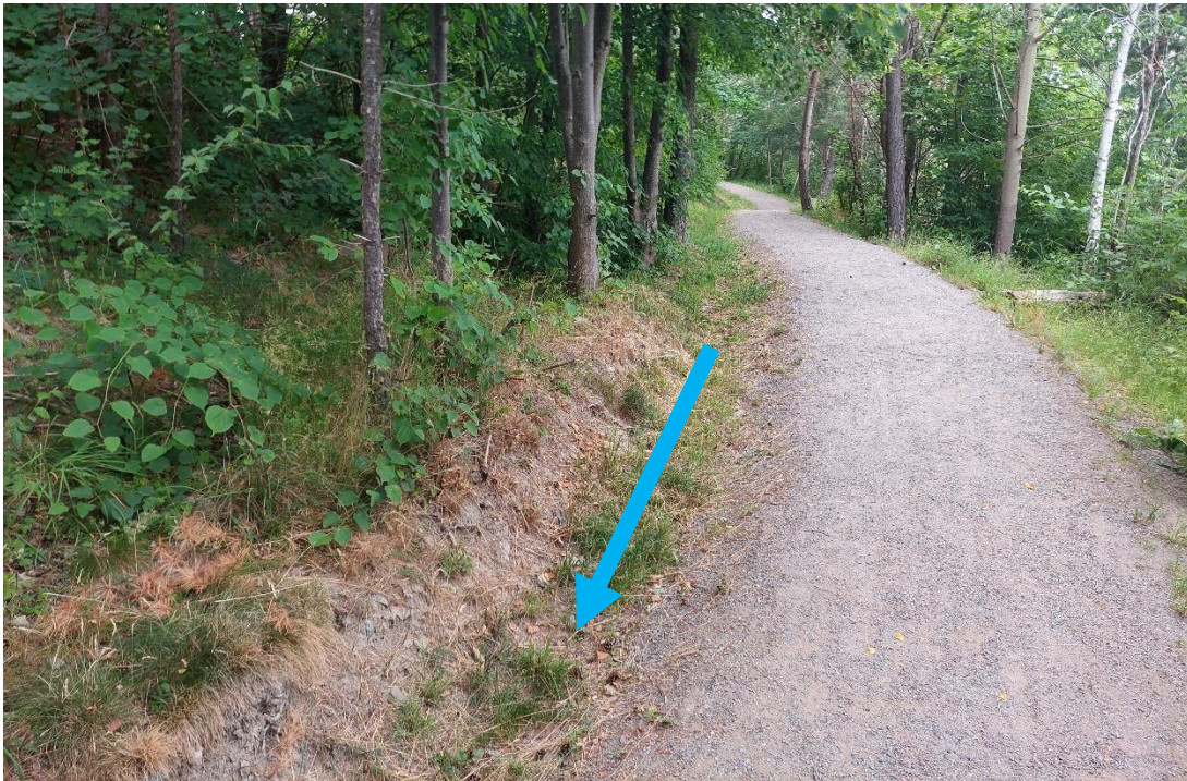
Figur 4-3. Fotografi på stig öster om plana höjden. Ett litet svackdike på västra sidan om stigen leder dagvatten längs med stigen. Fotografi taget i nordlig riktning.
