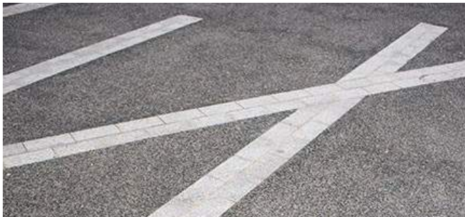
Figur 20: Band infällda i asfaltsyta
