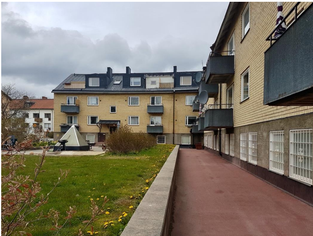
Balkonger och takaltaner vetter mot innergården.
