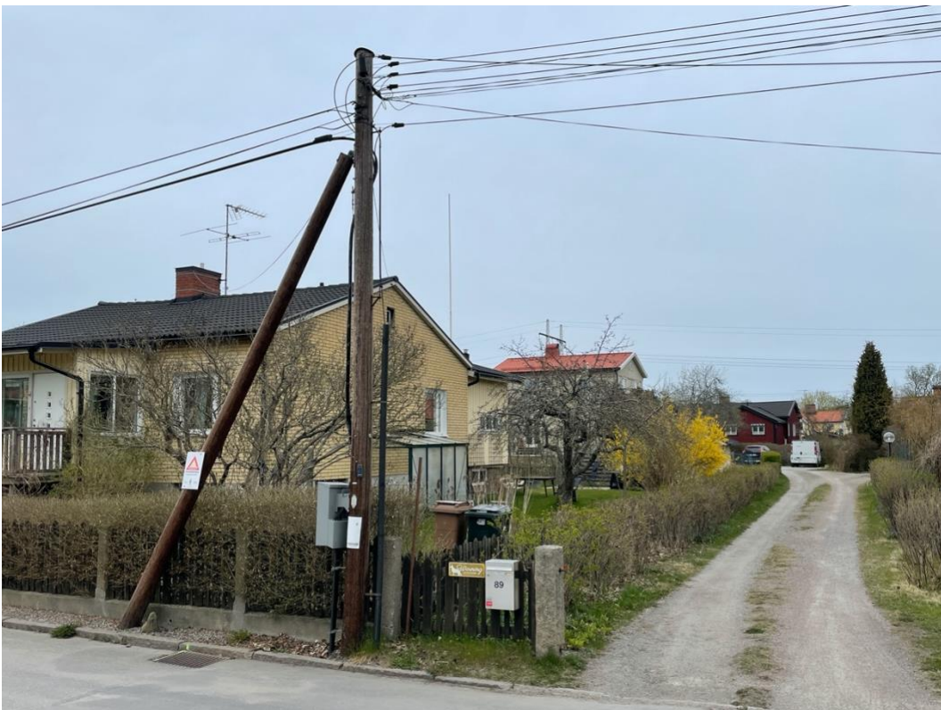
Villor i östra delen av Örby. Luftledningarna är ett karaktäristiskt inslag i området.
