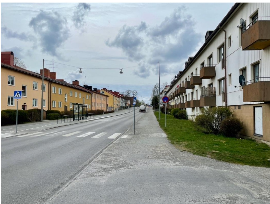
På höger sida om vägen ligger Kofångaren 24 och 25 och på andra sidan vägen Kullagret 6, 7 och 11. De dominerande fasadmaterialet är puts och tegel. Plåtfasaden på Kofångaren 24 och 25 är tillkommen i samband med en renovering.
