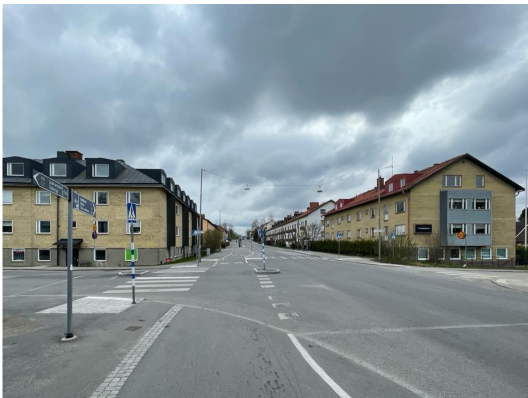
Första huset till höger i bild, Kofångaren 15, stod klart omkring 1970. De två tegelklädda husen bildar en entré till stadsdelen.
