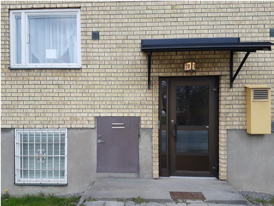
Entré ut mot Årdalavägen med aluminiumparti och skärmtak.
