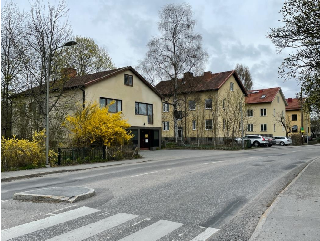
Startveven 11, 16, 9 och 8 utmed Årdalavägen. Husen är uppförda omkring 1940 och 1945. Den återhållna skalan ger en mjuk övergång till villabebyggelsen söderut.
