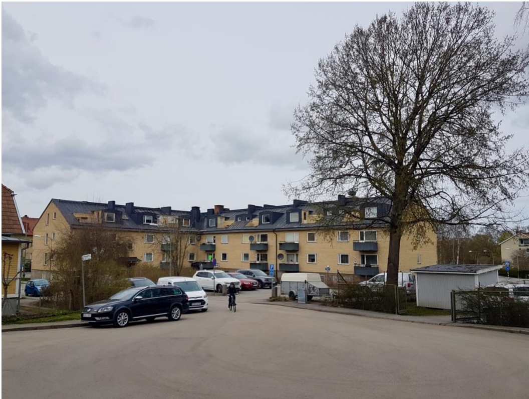
Punkteringen 3 söderifrån. I höger bildkant syns en förrådsbyggnad inom Punkteringen 7.
