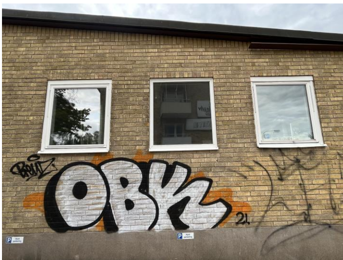
Ursprungliga pivåhängda fönster finns bevarade.
