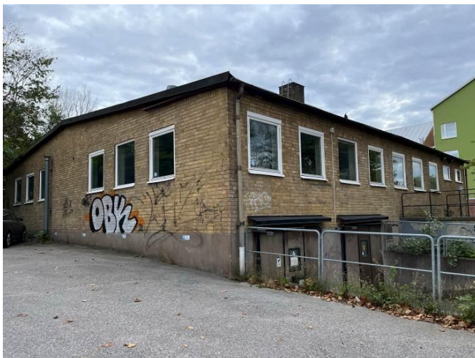
Fasad mot Malmköpingsvägen.
