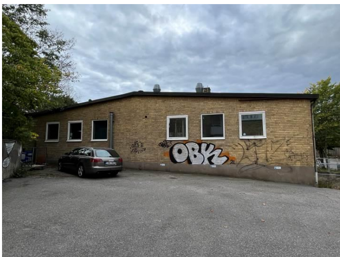
Fasad mot parkeringen, mot norr.
