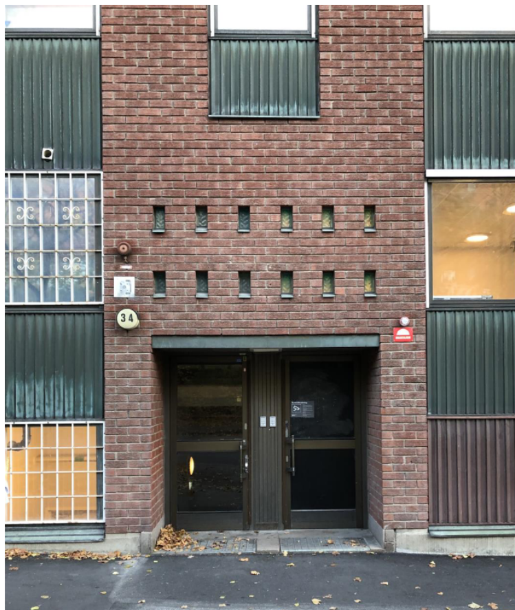
Befintlig byggnad på Kilabergsvägen 1, entré mot Tellusborgsvägen. Foto Studio Moi
