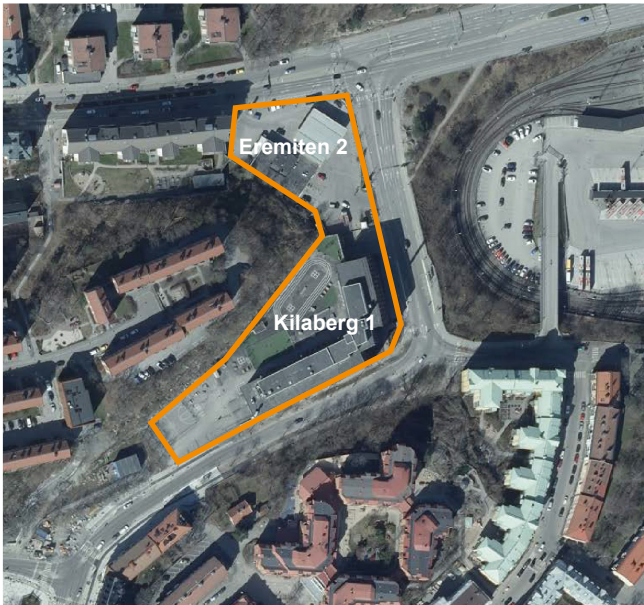
Ortofoto över planområdet Kilaberg med preliminär plangräns (ej fastställd vid upprättandet av denna rapport)
