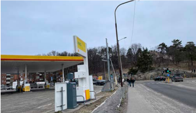
Miljön vid Kilberg 1 är bullrig och präglas av trafik längs vägen och in och ut från macken. Många skolbarn går på den smala trottoaren påväg till skolan.
