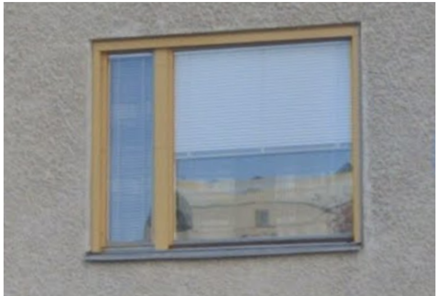
Inzoomat foto av befintlig fönsterkarm inom kv. Kvarnluckan 1.
