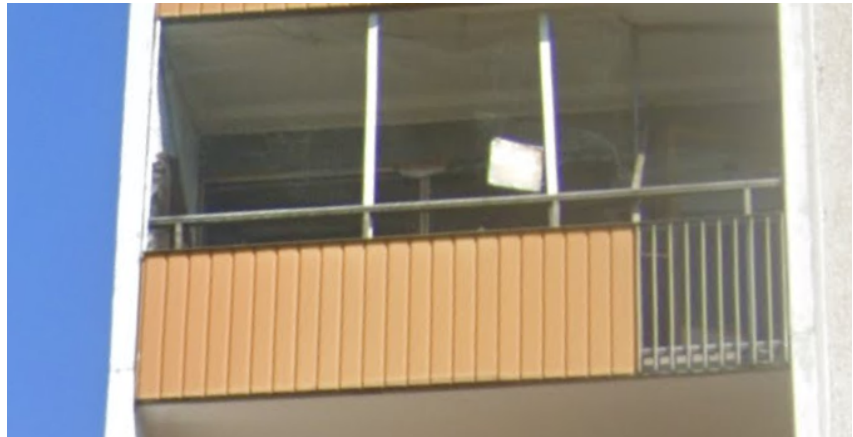
Inzoomat foto av befintligt balkongräcke inom kv. Kvarnluckan 1.
