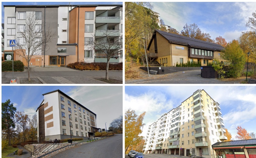
Bilder som visar befintlig bebyggelse längs Brattforsgatan, församlingslokalen, äldreboende och bebyggelse vid Filipstadsbacken. Bilder: Google street view
