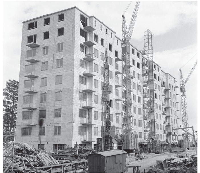
Filipstadsbacken under uppförandet 1957. De stora husen anpassades efter det kuperade landskapet. Källa: Stockholms stadsmuseum
