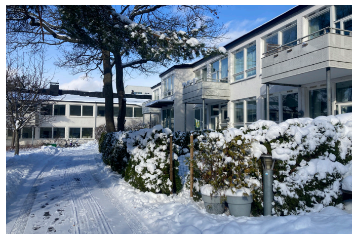
Tidigare skolbyggnader som bygts om till bostäder. Proportion, volym och skala utgör bärande karaktärsdrag.
