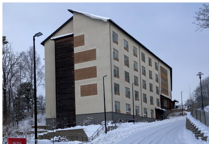
Byggnad från 2000-talet. Byggnadens takfall har anpassats efter områdets bebyggelse från 1950-talet.
