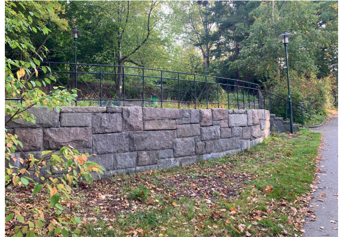
3. Stödmur i natursten skapar en platå med vistelseyta. Platån nås av trappa i natursten. Muren kantas av smäckert järnräcke. Platån ramas in av grönska och en stödmur åt norr.
