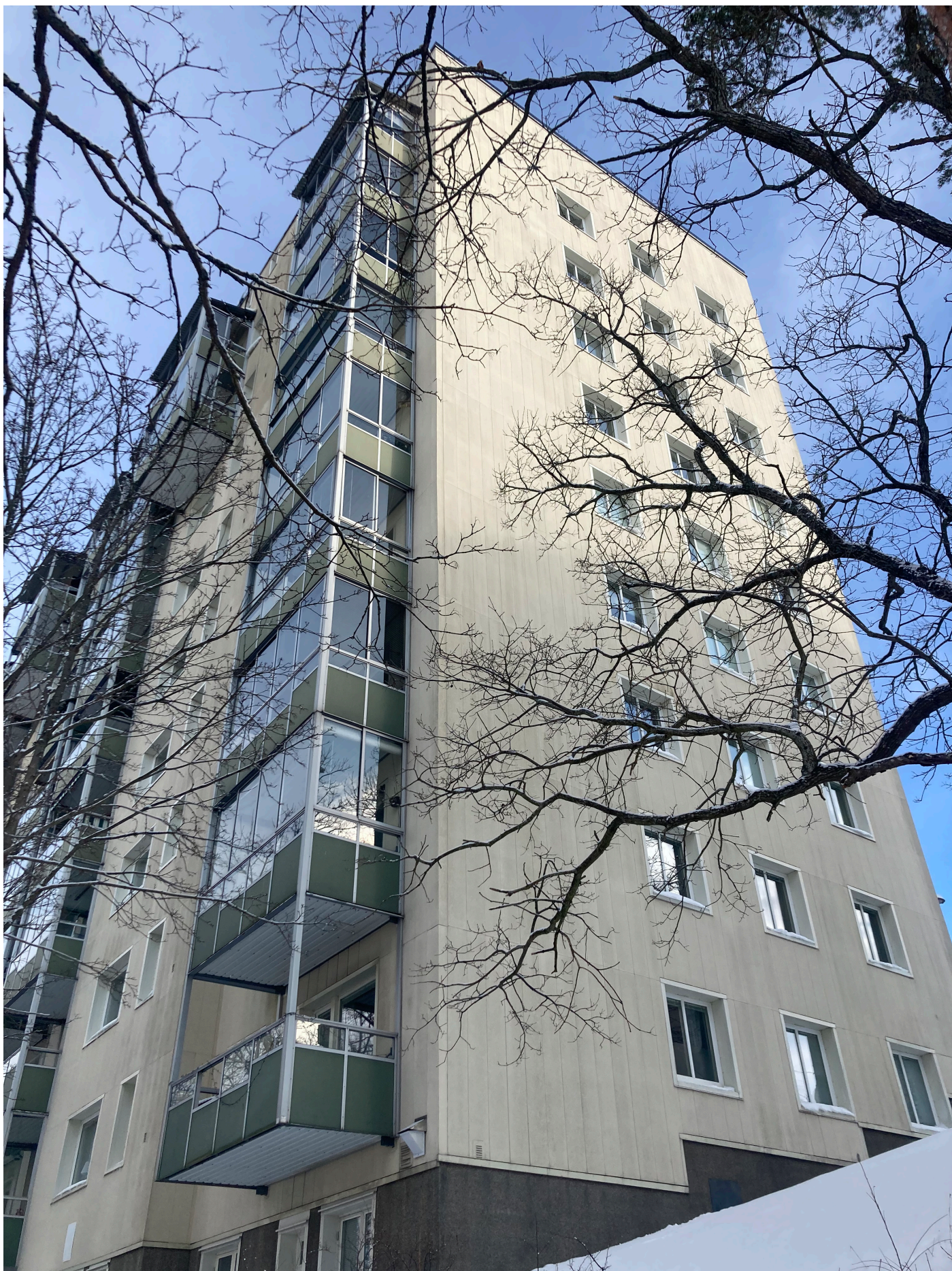
Flerbostadshusens fasadmaterial är sekundära till följd av tilläggsisolering. Även balkongerna är bytta. Fasadkomposition, volymverkan och den terränganpassade sockeln utgör således bärande karaktärsdrag.
