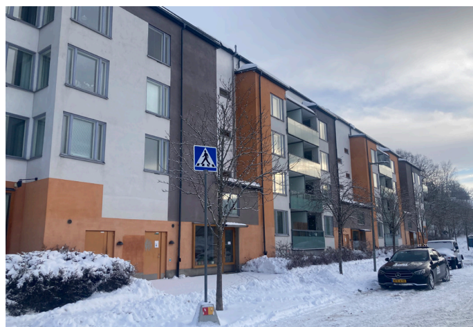
Bostadshus från 2000-talet. Byggnadernas placering och anslutande gaturum har en stadsmässig prägel. De uppbrutna fasadernas kombinerar olika material och kulör.
