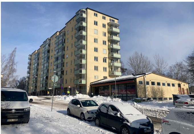
Skivhus med förskjutna fasadpartier. Diskreta välbevarade entrér.
