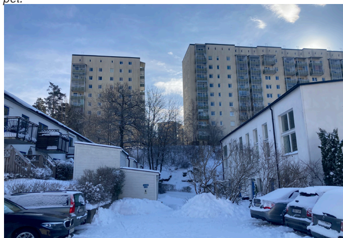
Flerbostadshuset har en jämn siluett. De tidigare skolbyggnaderna är belägna i de flackare delarna av landskapet.
