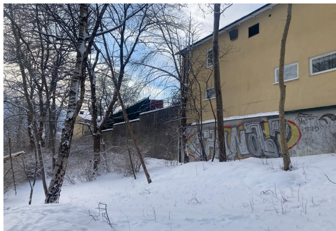
Stödmur mot Filipstadsbacken med tidstypiskt räcke. Muren sammanbinder de två tidigare butiksbyggnaderna på Filipstadsbacken och är en äldre kvarvarande struktur. I slutningen finns bostadsnära natur.
