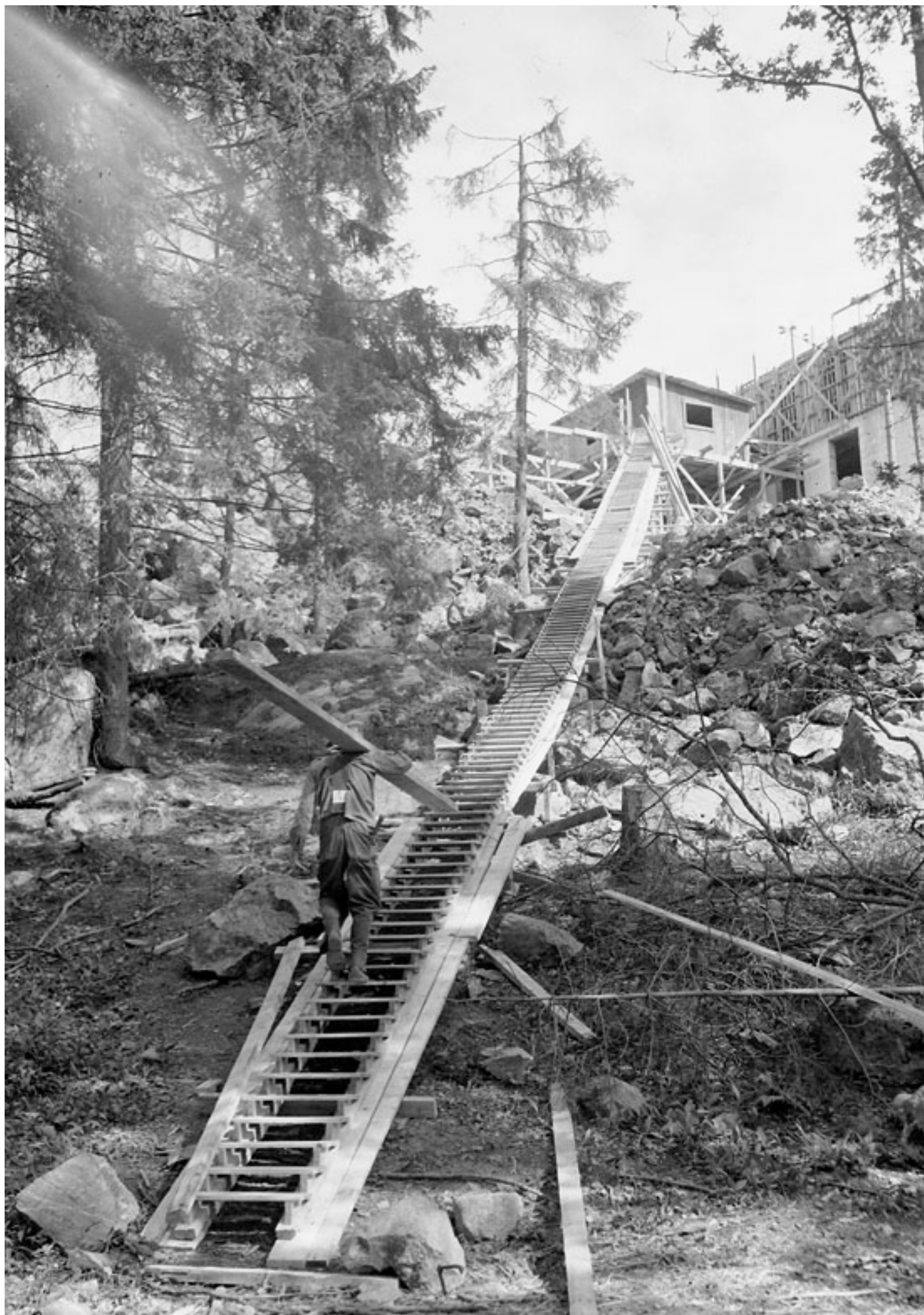
Byggnader under uppförande på Filipdalsbacken. Foto: Olle Widfeldt. Källa: Stockholms stadsmuseum, 1956
