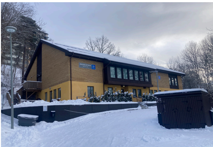
Församlingshem uppfört på 1980-talet. Det centralt placerade panelklädda burspråket är karaktärsskapande.
