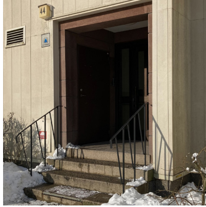
Ursprungligt entréparti. Trappor i granit med tidstypiska räcken med ett och geometriskt uttryck. Markering av portnummer har en äldre prägel.
