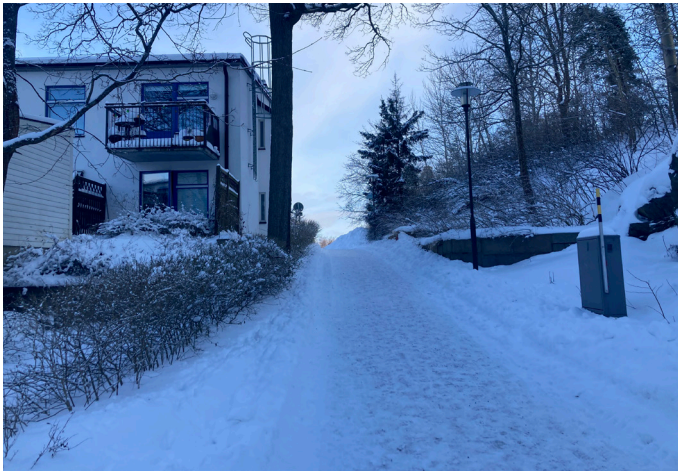
6. Gångväg som leder mot den tidigare skolan. En stödmur i natursten skapar terrassering.
