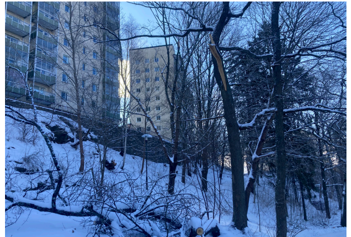
7. Stödmuren ger en större bakgård åt flerbostadshusen. Murarna i natursten har ett enhetligt uttryck.
