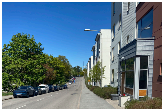
1b. Nybyggda punkthus. Vy mot norr
