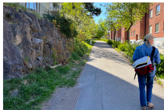
7b. Passage mellan kvarteret och bergvägg. Vy mot söder.
