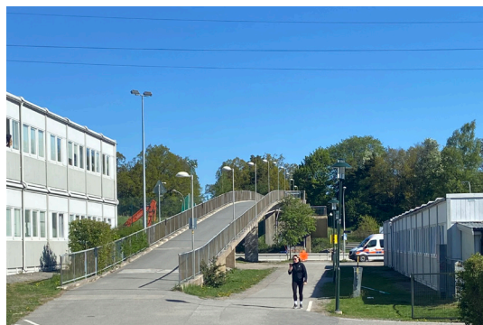
5b. Bron över Tyresövägen i norr.
