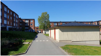
Befintligt cykelhus på gården i kvarter Wienerkransen 3.
