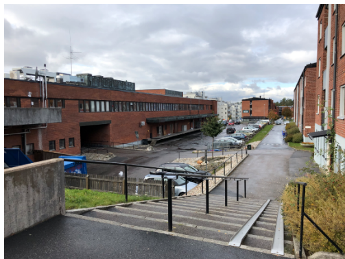
Bilden visar lastgatan bakom centrumbyggnaden med portiken som är en del av det röda stråket.
