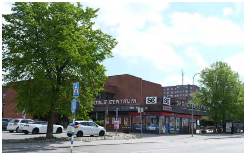
Fristående kiosk som sammanbinds med centrumhuset med ett kopparklätt skärmtak. Bild: Nyréns Arkitektkontor
