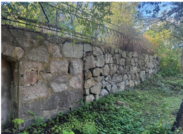
Källargrunden och terrassmuren sett från nordöst.
