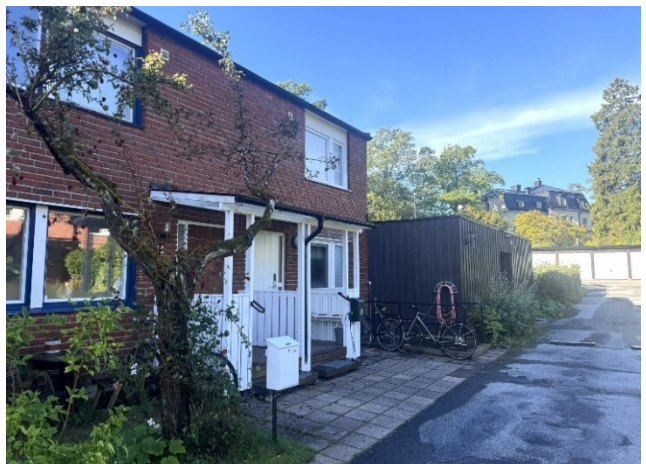
Radhus söder om planområdet med entréer och utstickande lågdela. Sett från nordöst.
